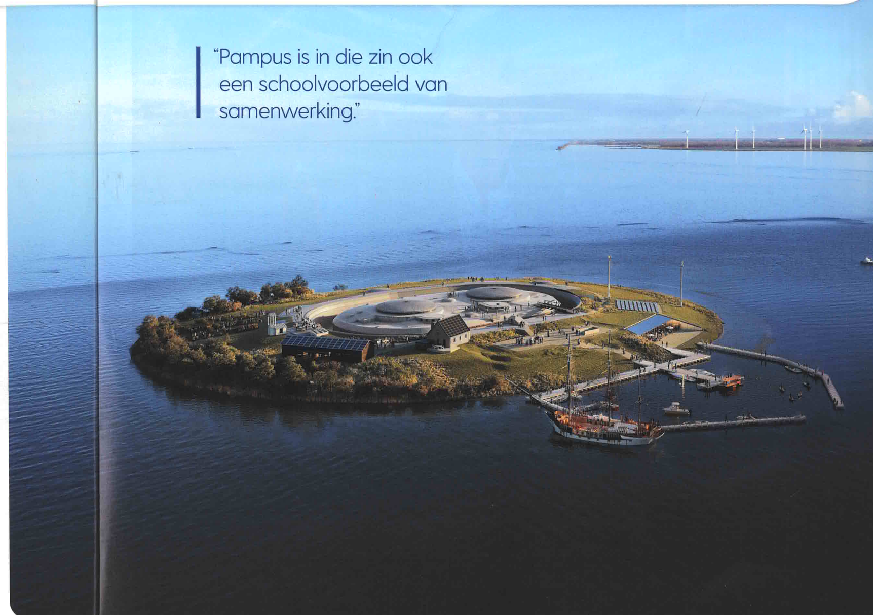
Door het gebruik van duurzame energiebronnen op het eiland, worden de dieselaggregaten overbodig in de toekomst.
